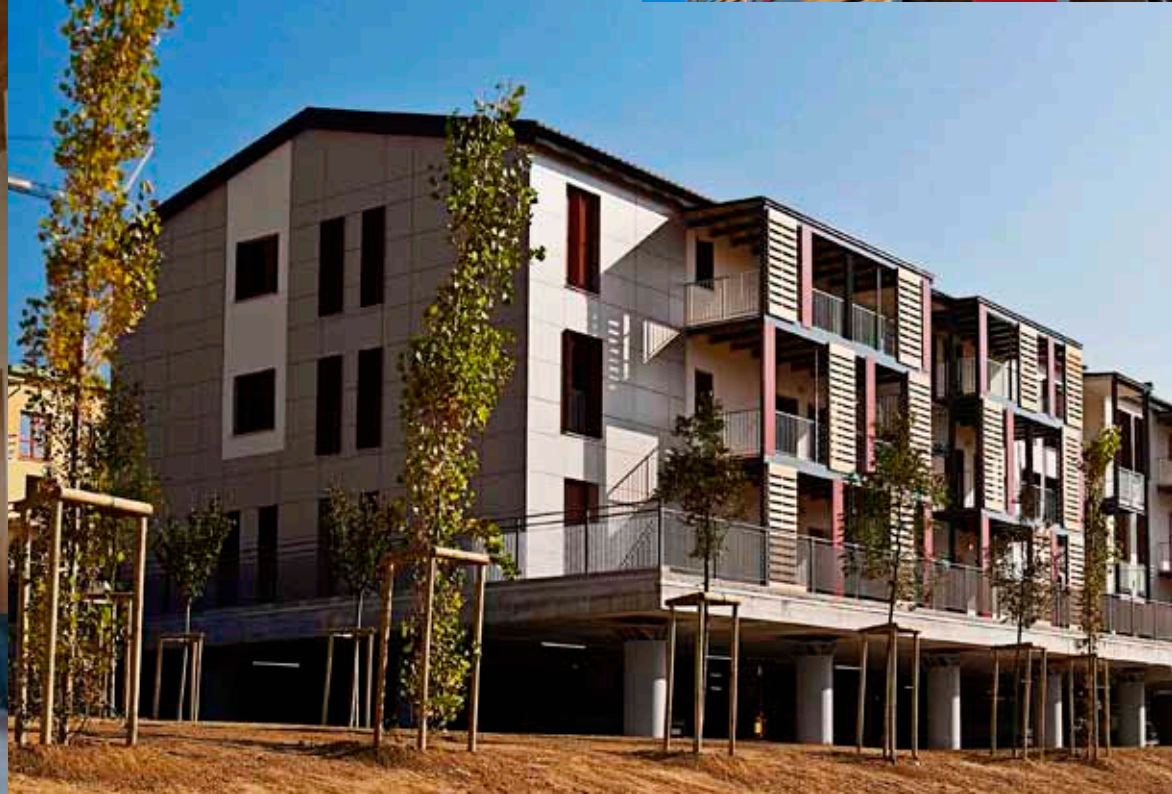
Qui sopra e in alto: abitazioni e dettaglio balconi e frangisole in legno di larice siberiano, L'Aquila. Gli edifici multipiano realizzati in Xilam sono ad altissima resistenza sismica.
